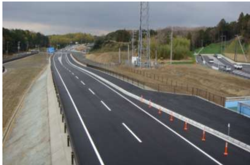
津(河芸)工区完成【平成24年3月】
