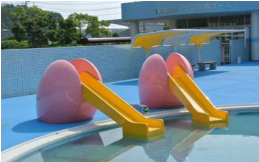
幼児プールに滑り台を設置
