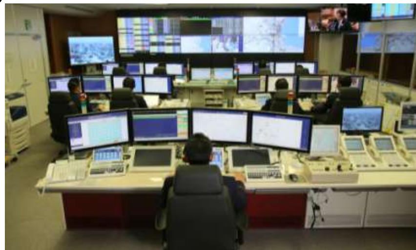
消防指令センター(消防本部内)
