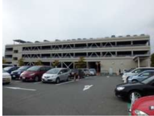
⑫ 津リージョンプラザ 立体駐車場
