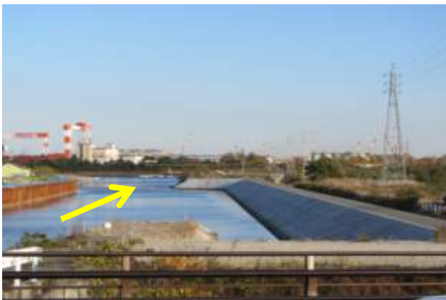
引堤により完成した 河口部(右岸)
