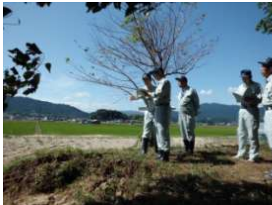
《安濃川堤防破堤現場（津市安濃町浄土寺）》
