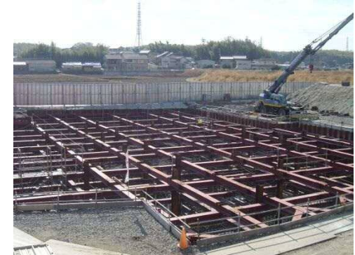
整備を進める半田川田ポンプ場
