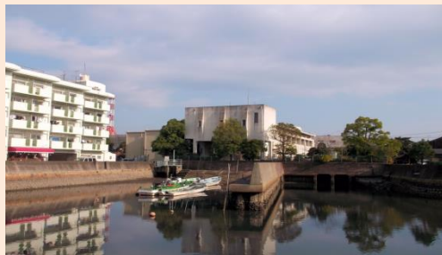
極楽橋ポンプ場
