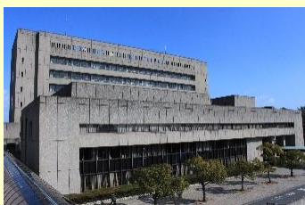
本庁舎設備等の大規模改修
