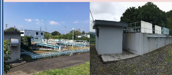
豊が丘団地汚水処理場
