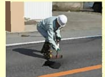
道路の路面復旧
