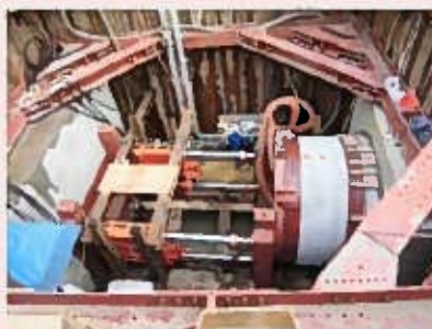
※雨水幹線の推進工事
