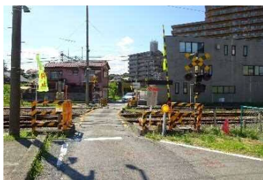
【拡幅を行う大谷踏切】
