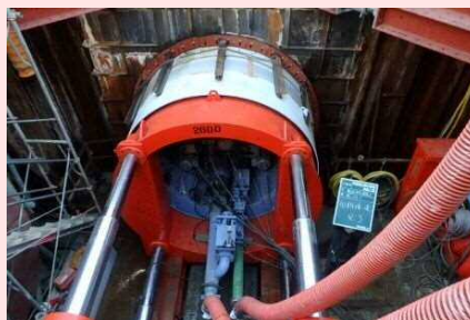
※雨水幹線の推進工事
