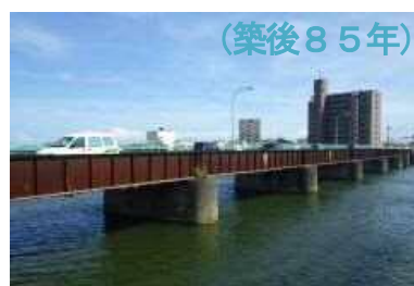
【架け替えを行う津興橋】
