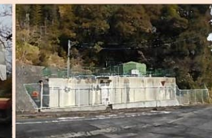
ピュアタウン汚水処理場
