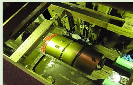
雨水管渠推進工事の様子
