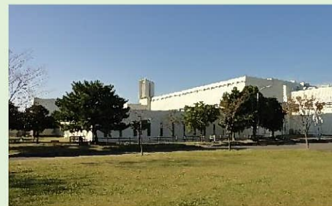
中央浄化センター
