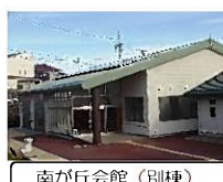
南が丘会館(別棟)
