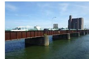
【架け替えを行う津興橋】
