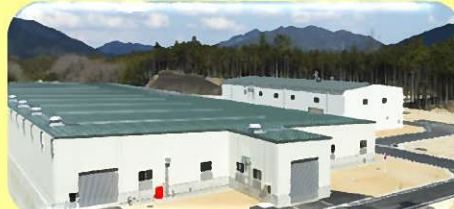
一般廃棄物最終処分場
