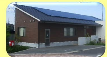
太陽光発電システム
