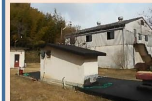
殿舟団地汚水処理場
