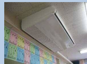
【エアコン整備】
