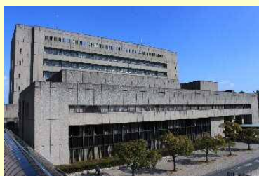
本庁舎の大規模改修
