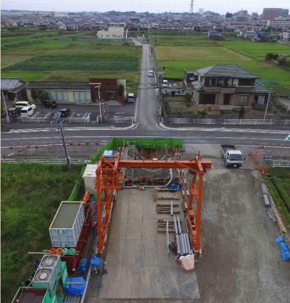
半田川田第1雨水幹線 築造工事
