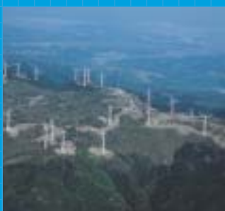
久居榊原風力発電施設（久居市）
