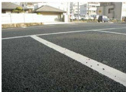
駐車場等の透水性舗装
