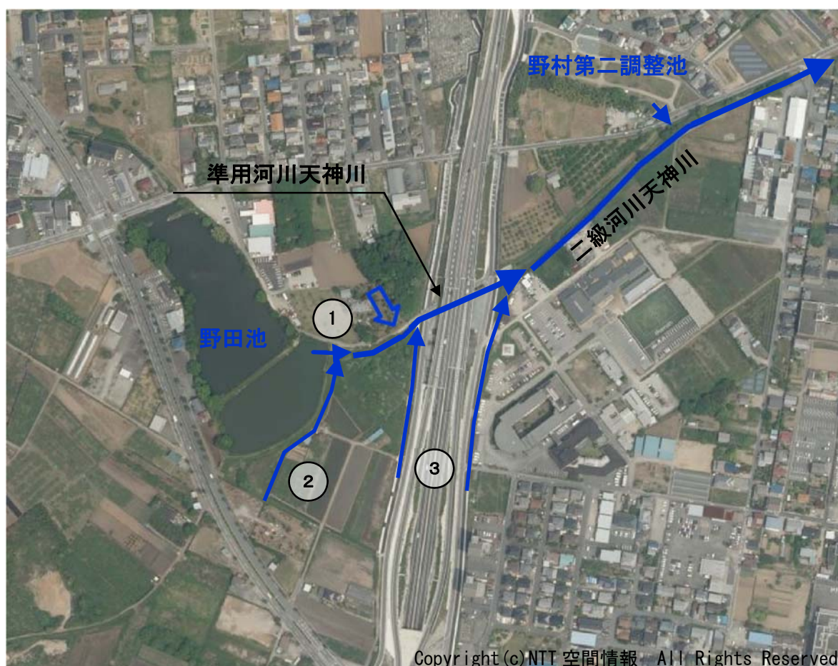
図－30 準用河川天神川への流入状況
