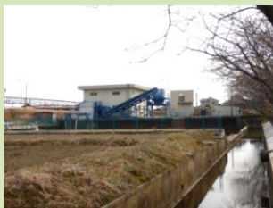
納所排水機場
