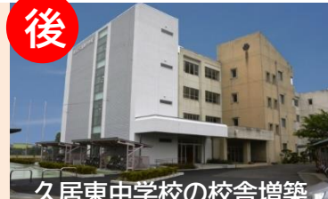
久居東中学校の校舎増築
