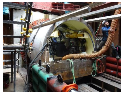
第2雨水幹線φ2000の施工状況
