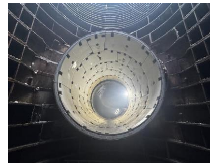
到達立坑から見たφ3400の管内
