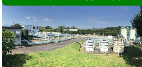
豊が丘団地の共同污水处理施設
