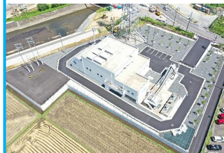
天神ポンプ場 (令和5年9月運転開始)
