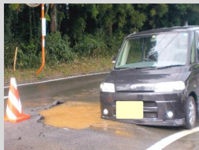
老朽化した水道管の破損により陥没した道路
