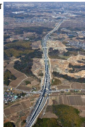
国道23号中勢バイパス(鈴鹿・津工区)7工区開通 (平成31年2月)
