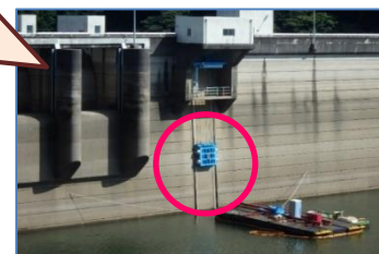
安濃ダム・洪水放流非常用ゲート補修
