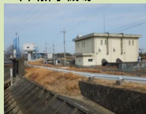
中山排水機場
