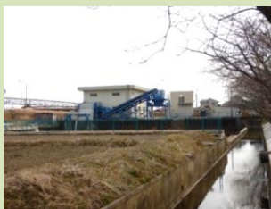
納所排水機場
