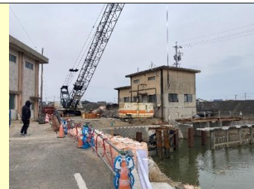
湛水防除事業 (千里地区)
