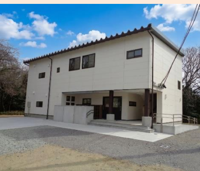
令和7年度に整備した 高茶屋地区放課後児童 クラブ新築工事
