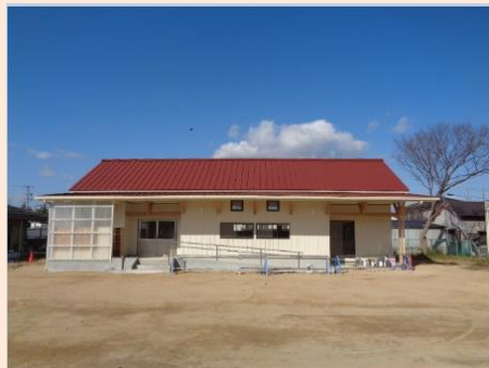
令和6年度に整備した 誠之放課後児童クラブ 新築工事
