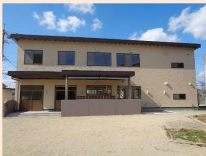
令和7年度に整備した 修成地区放課後児童 クラブ新築工事
