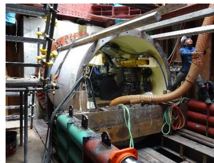
第2雨水幹線φ2000の施工状況
