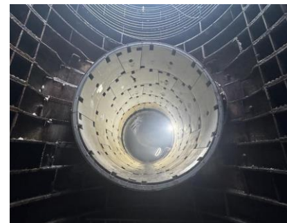
到達立坑から見たφ3400の管内
