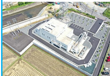
天神ポンプ場 (令和5年9月運転開始)
