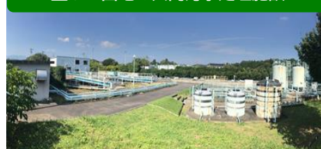
豊が丘団地の共同污水处理施設
