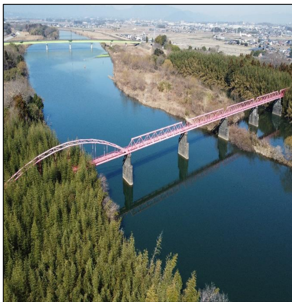
水管橋(劣化診断・耐震診断)
