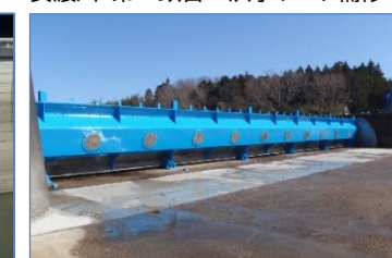
安濃川・第三頭首工洪水ゲート補修
