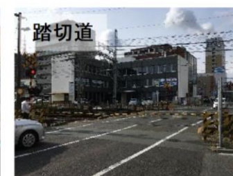
踏切道 歩道がなく危険で、遮断時間も長い
