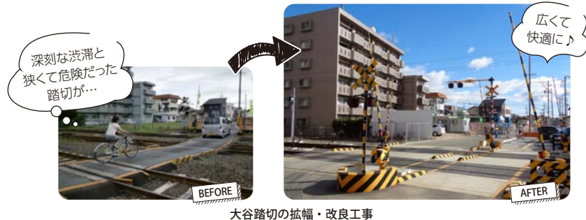
大谷踏切の拡幅・改良工事
