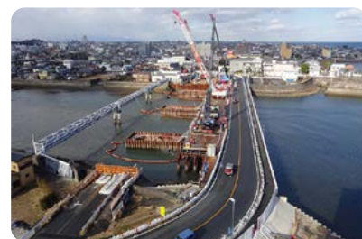
津興橋の架け替え工事
