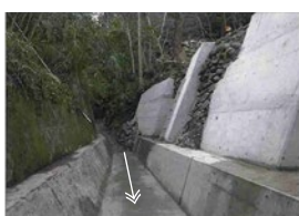
王子討谷川の護岸整備
