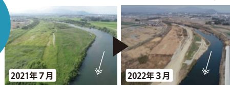
雲出川の河道掘削
