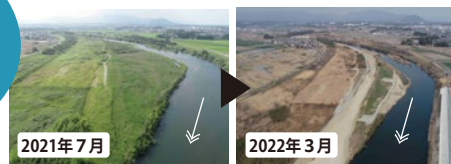
雲出川の河道掘削
