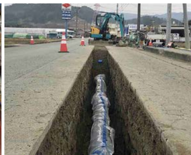
配水管布設工事の様子
