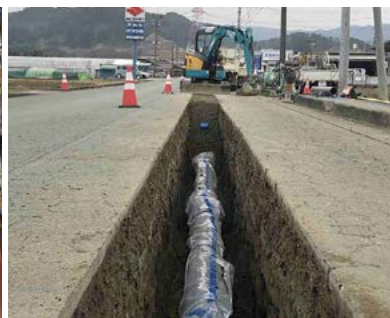
配水管布設工事の様子
