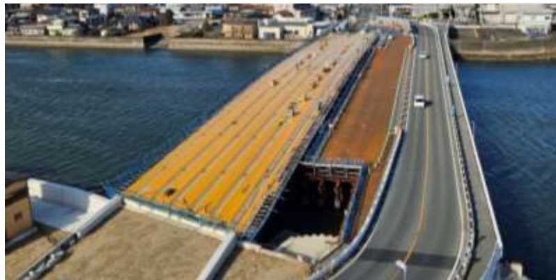
仮橋による通行時
