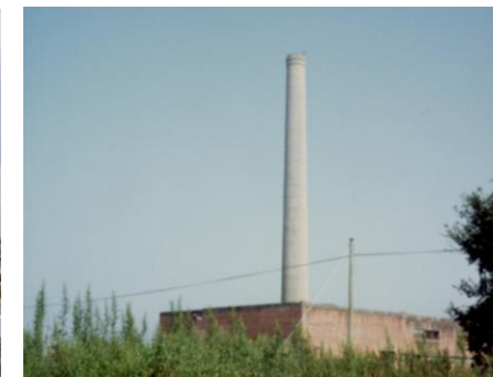
汽缶場と煙突（平成 11 年に解体）
