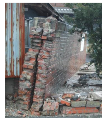
②レンガ堀（旧正門付近） （令和 5 年に解体）
