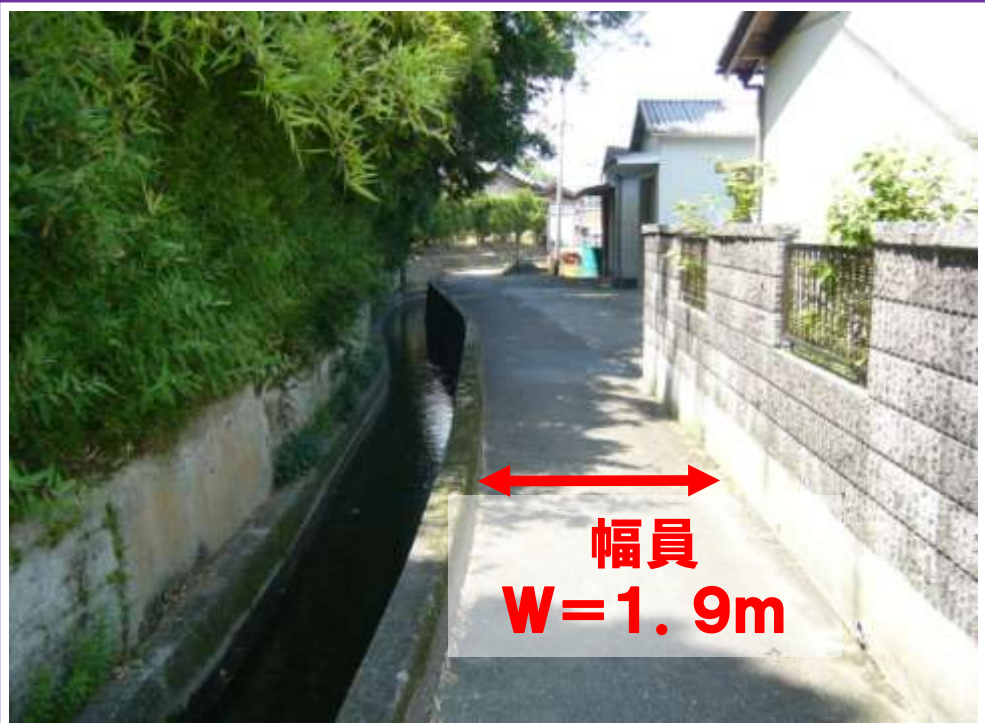
工事前の様子
