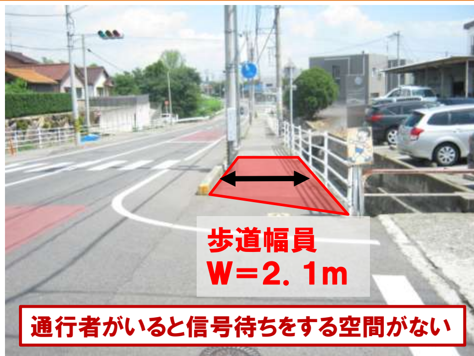
工事前の様子
