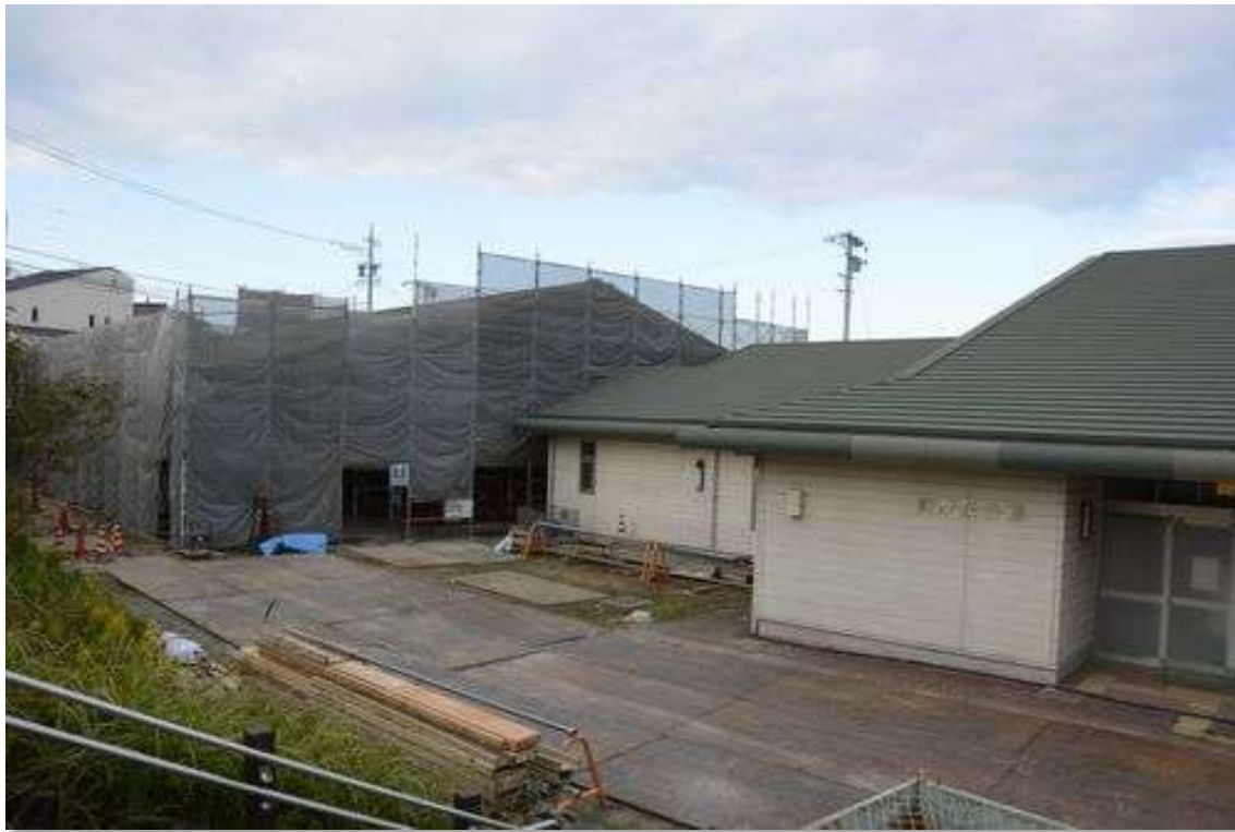
南が丘会館西隣に建設中 10月23日撮影
