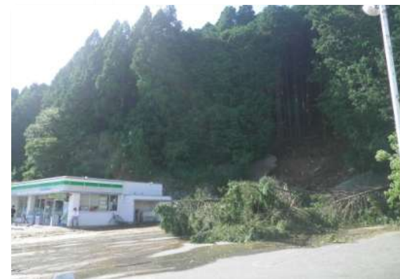
山腹の崩壊 (白山町垣内地内)
