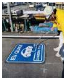
▲ 路面サインはガスバーナーで焼き付けます
