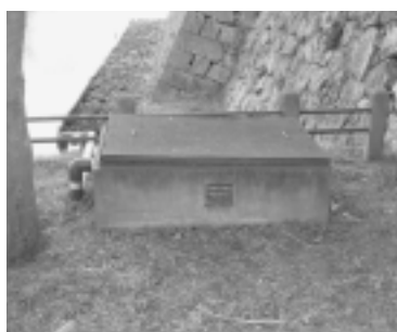
16 ポンプ道施設
