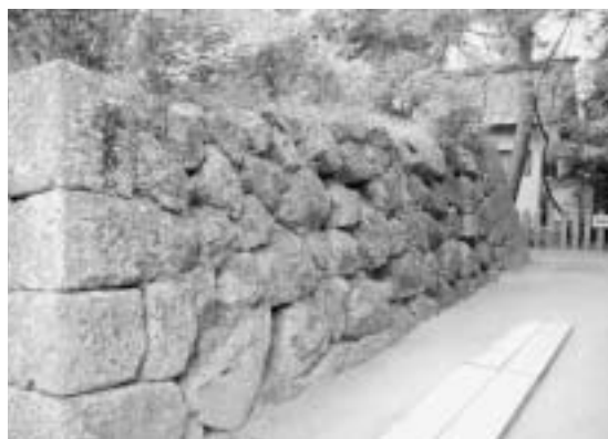
本丸南西角石垣（北西から）
