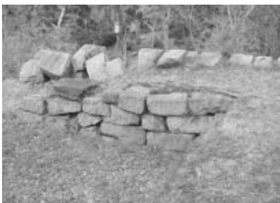
12 天守台上部北辺石垣の崩れ（南から）
