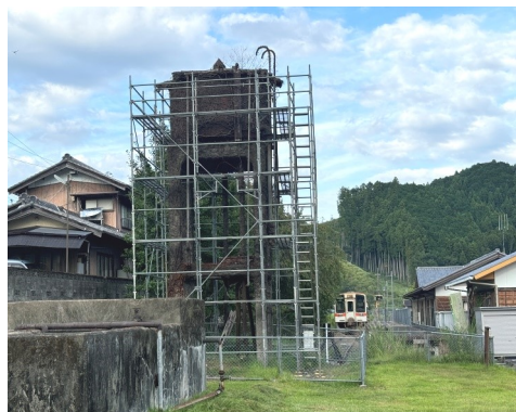
現況調査中の給水塔
