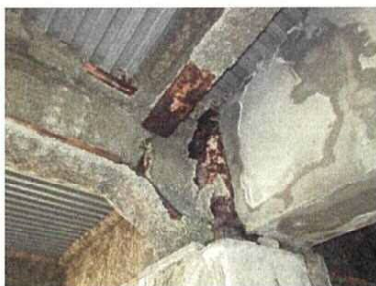
フェニックス通り駐車場 耐火被覆
