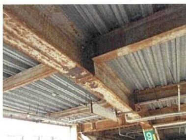
アスト駐車場 支柱
