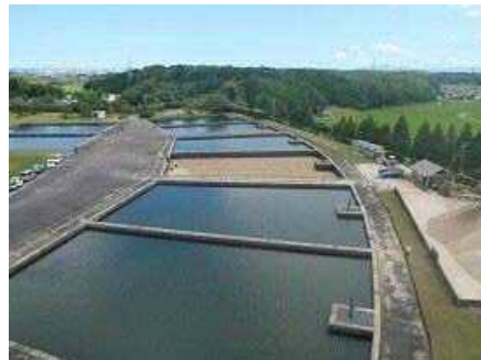
図 3.1 緩速ろ過池（片田浄水場）
