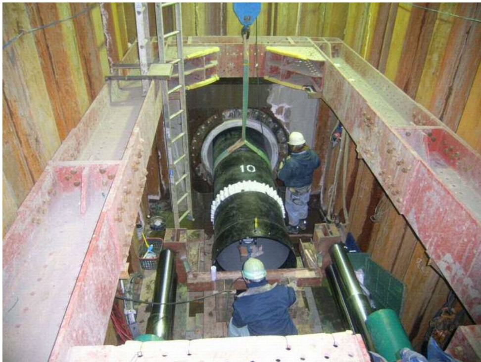
図 5.5 大口径管布設状況（基幹管路の耐震化 口径 800 ミリ）
