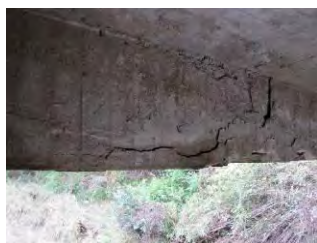
（床版の鉄筋露出）
