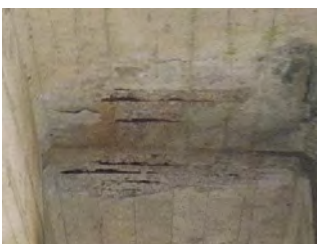
（床版の鉄筋露出）
