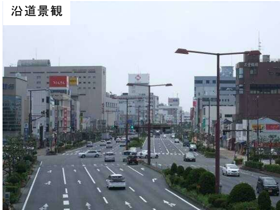
国道 23 号丸之内周辺（津地域）
