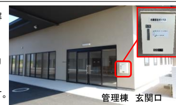
管理棟 玄関口
