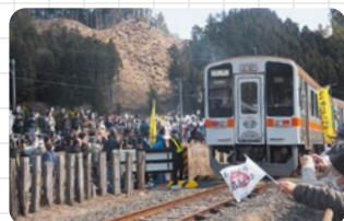
平成28年3月 全線復旧
