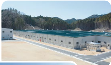
一般廃棄物最終処分場
