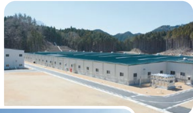
一般廃棄物最終処分場
