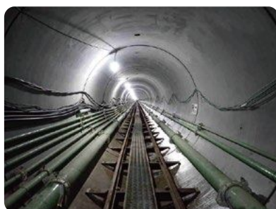
管径2.2mの雨水管の内部
