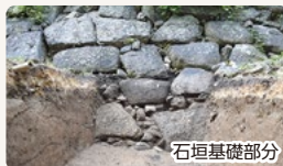
石垣基礎部分
