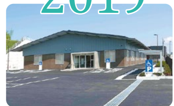
津南防災コミュニティセンター
