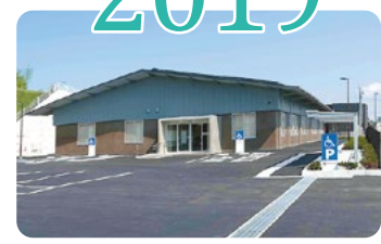
津南防災コミュニティセンター
