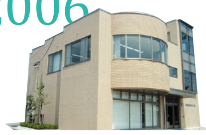
賛岐地区防災コミュニティセンター
