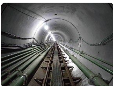
管径2.2mの雨水管の内部
