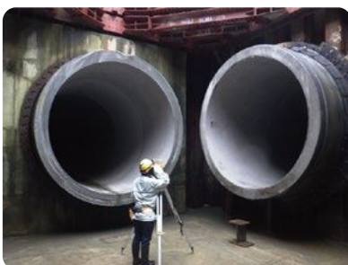
管径2.8mと2.6mの雨水管の合流箇所
