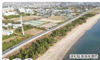
津松阪港海岸堤防
