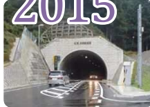
県道一志美杉線矢頭トンネル
