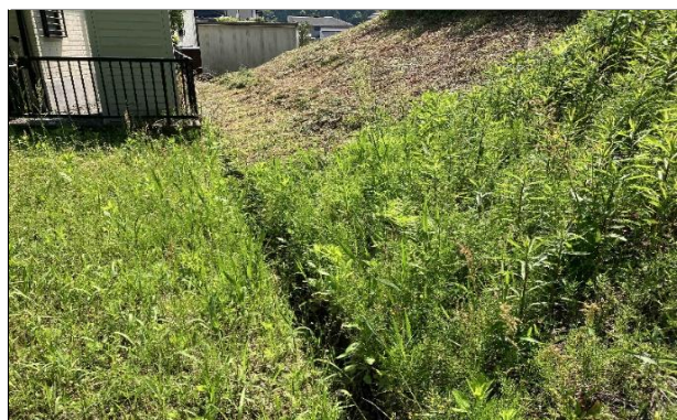
8 敷地奥の状況
