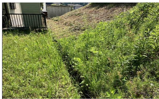
8 敷地奥の状況
