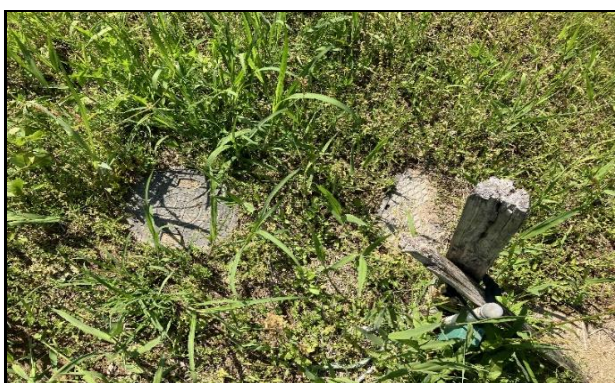
3 供給施設の状況
